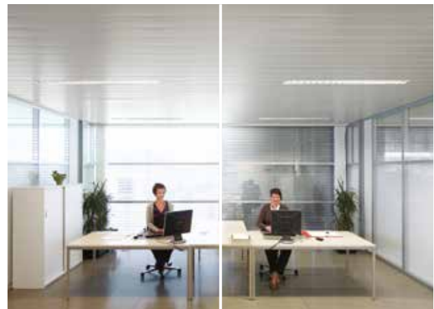
Daglichtafhankelijke regeling past de lichtstroom van de armatuur aan op basis van het binnenvallende daglicht.
